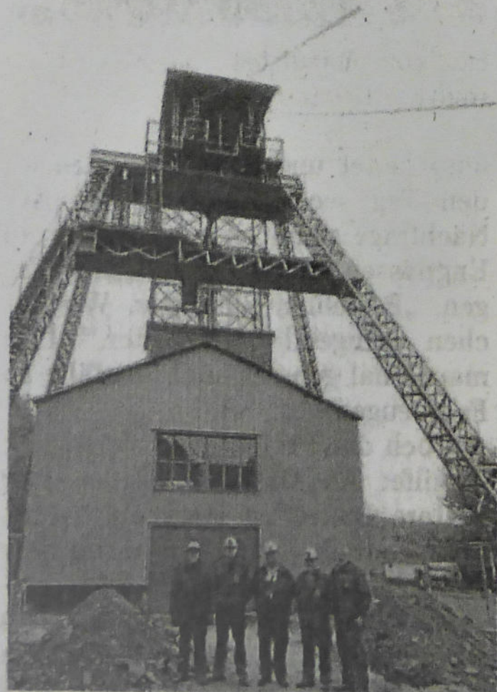
Das neue Seil ist auf das Fördergerüst gezogen, Bauleiter Moris Harzer (2. von rechts) ist zufrieden.
